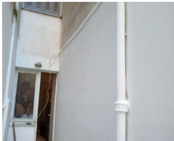
Εικ. 3: κατακόρυφος σωλήνας αποχέτευσης σε πλαϊνό εξωτερικό τείχος
