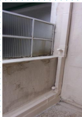
Εικ. 9: Οριζόντιο και κατακόρυφο τμήμα υδρορροής που διασχίζει μπαλκόνι, κατεβαίνοντας από την ταράτσα, προς το πεζοδρόμιο – Είναι αμφότερα κοινόκτητα/κοινόχρηστα.
